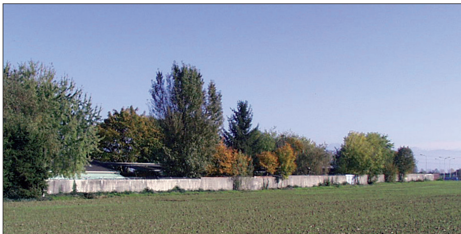
Bien que confortablement lové dans son écrin de verdure, le Refuge de l'Asse a pris de l'âge. Construit il y a plus de 40 ans, il a besoin d'améliorations et de réfections, notamment en matière d'isolation et de chauffage.
